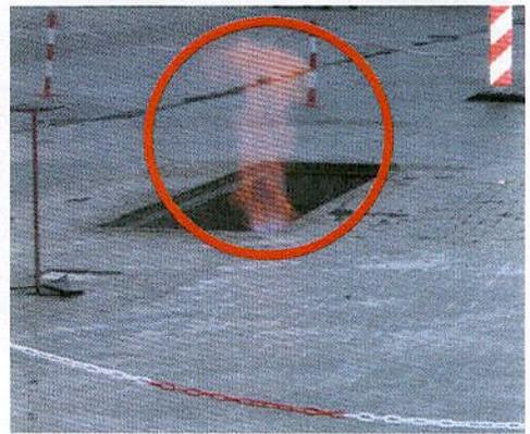
einer vorhandenen Druckleitung muss von den Teilnehmern demonstriert werden. Dabei wird die Wirkung eines unvorhergesehenen Baggerschadens auf eine Hausanschlussleitung bei totalem Abriss (Foto li.u.) von den Teilnehmern live erlebt.
