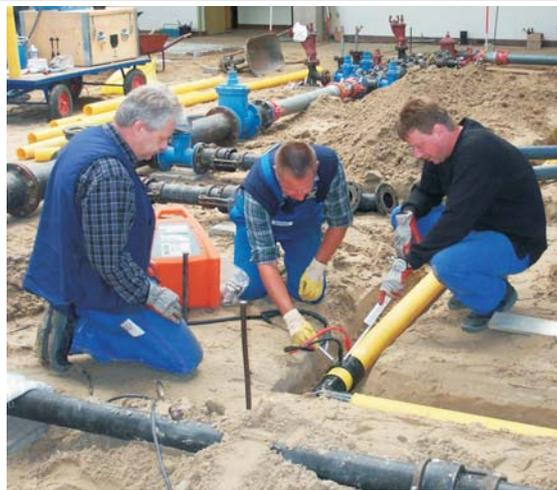
21 angehende Netzmonteur (Foto li.) der **Stadtwerke Bremen** absolvierten den Ausbildungsteil Rohrleitungsbau als Vorbereitung auf die praktische Abschlussprüfung im **Bau-ABC Rostrup**. Im Ausbildungsprogramm standen unter anderem das Herstellen einer Trinkwasserversorgungsleitung DN 200, die Erstellung einer Gasversorgungsleitung d 110, sowie das Sperrern einer Leitung mit dem Zweifach-Blasensetzgerät und das Anbohren unter Druck.
