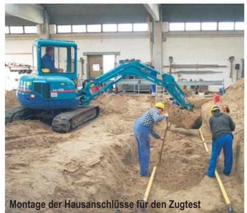
Montage der Hausanschlüsse für den Zugtest
