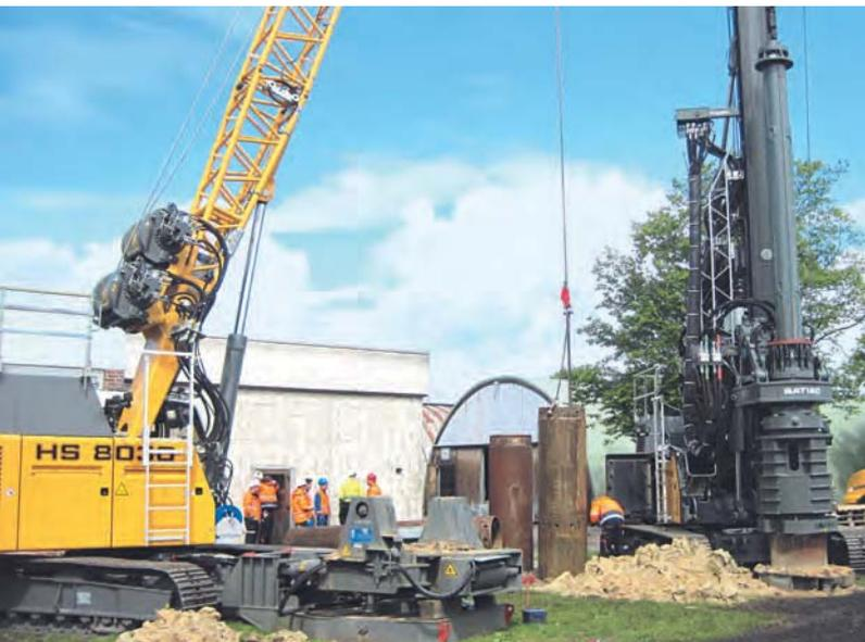
Spezialtiefbauer beim Training mit Seilbagger und Großdrehbohrgerät.
